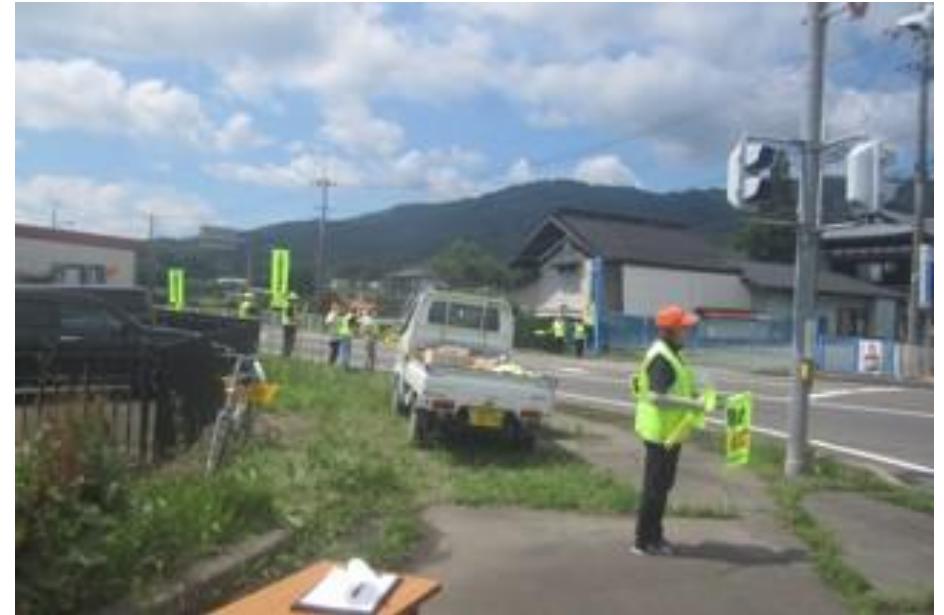
令和6年7月22日 県道13号山王海土地改良区前交差点
